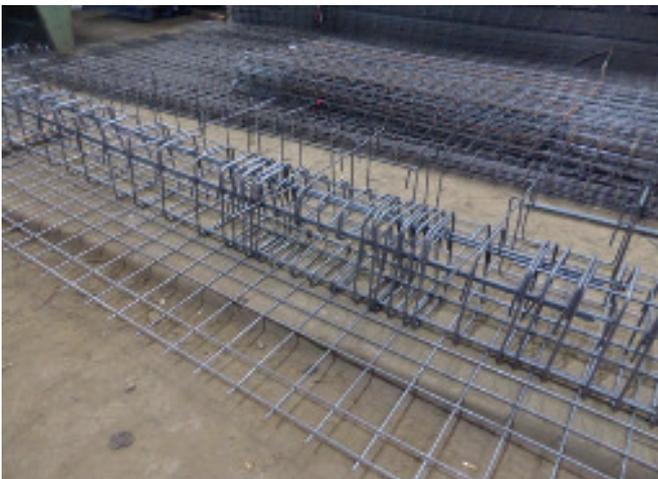
*Derzeit konventionell in Handarbeit erstellte Bewehrungskörbe für eine Rippendecke werden zukünftig von Robotern vollständig zusammengesetzt.*
