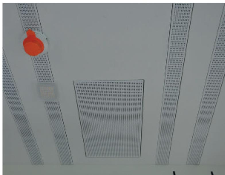
*Endprodukt der vorgefertigte Betondecke: Nutzbar wie eine angehängte Decke mit den verschiedenen Komponenten für die Gebäudetechnik.*
