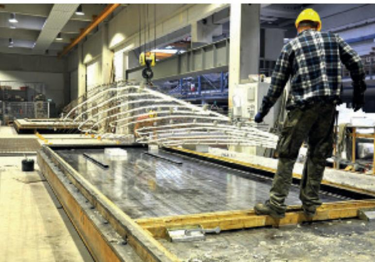
Vorgefertigte Bewehrungseinheit mit fixierten Rohrleitungen für den Einbau in die Schalung im Fertigteilwerk.
