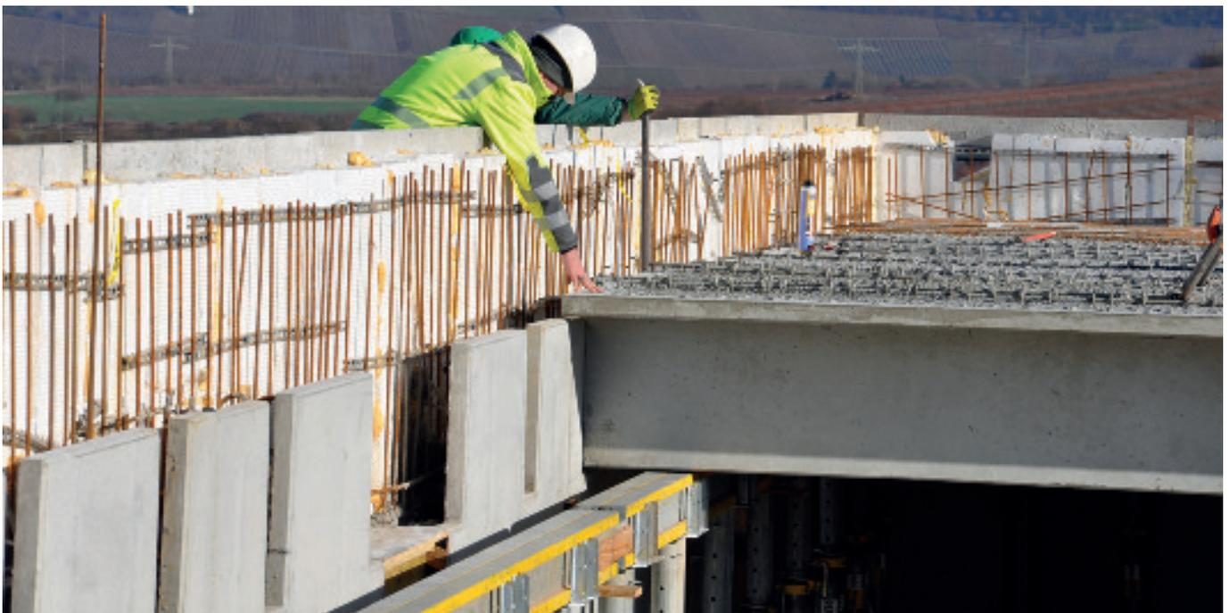
Hallenkonstruktion in kompletter Vorfertigung: abgestimmte Thermowände in Verbindung mit einer weitgespannten n-Platte.
