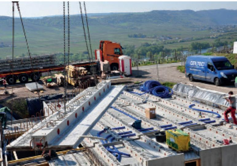
Vorgefertigte Deckenelemente mit Sandwichquerschnitt (Ceiltec®-B) zur Nutzung des Deckenhohlraums für die Leitungen der Gebäudetechnik.
