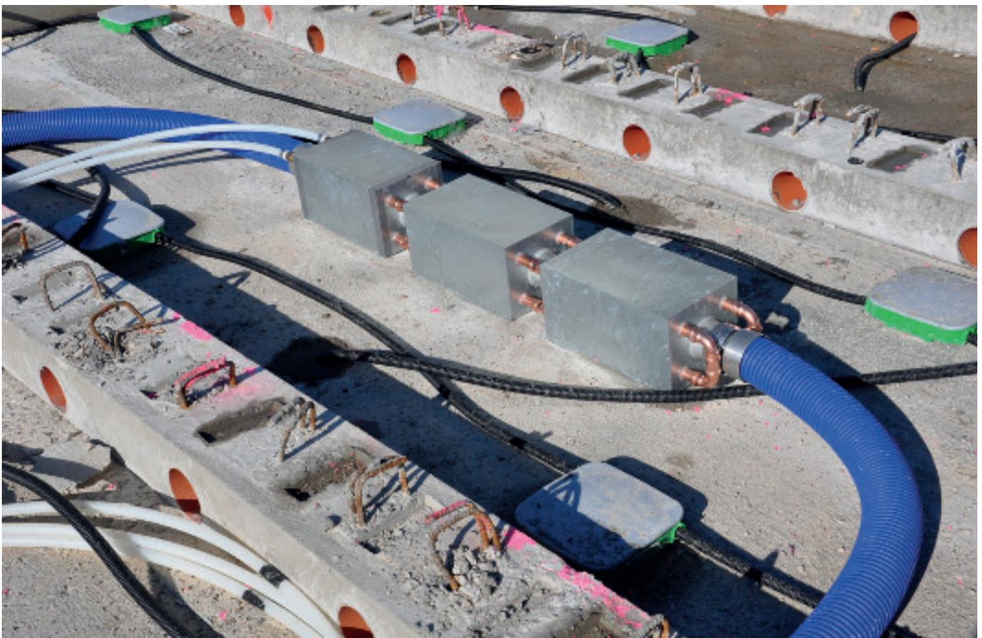
Dezentrale Wärmespeicher (Ceiltec®-Container) innerhalb des Deckenhohlraums mit Anschluss an die integrierte Rohrleitung der Bauteilaktivierung und der Lüftung.
