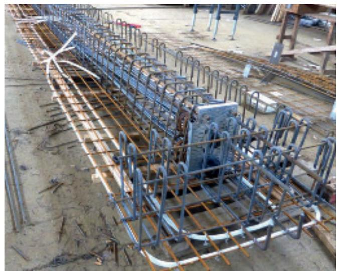
Komplett vorgefertigte Bewehrungseinheit für eine Rippendecke (inkl. der Rohrleitungen zum Kühlen/Heizen; dem Vorspannkabel; dem Verankerungsdetail für die Abschalung mit einem vorgefertigtem Blech).
