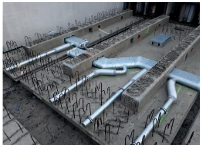
Vorgefertigte Deckenplatten mit integrierten Lüftungsleitungen, die im Werk bereits montiert werden und auf der Baustelle zu einem Strang verbunden werden (Ceiltec®-B).
