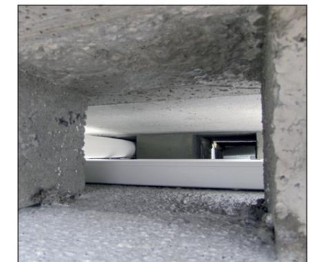
**Das Ceiltec-Sandwich-Element bietet im 20 Zentimeter großen Decken-Hohlraum ausreichend Platz für eine geordnete und kontrollierte Leitungsführung.**
