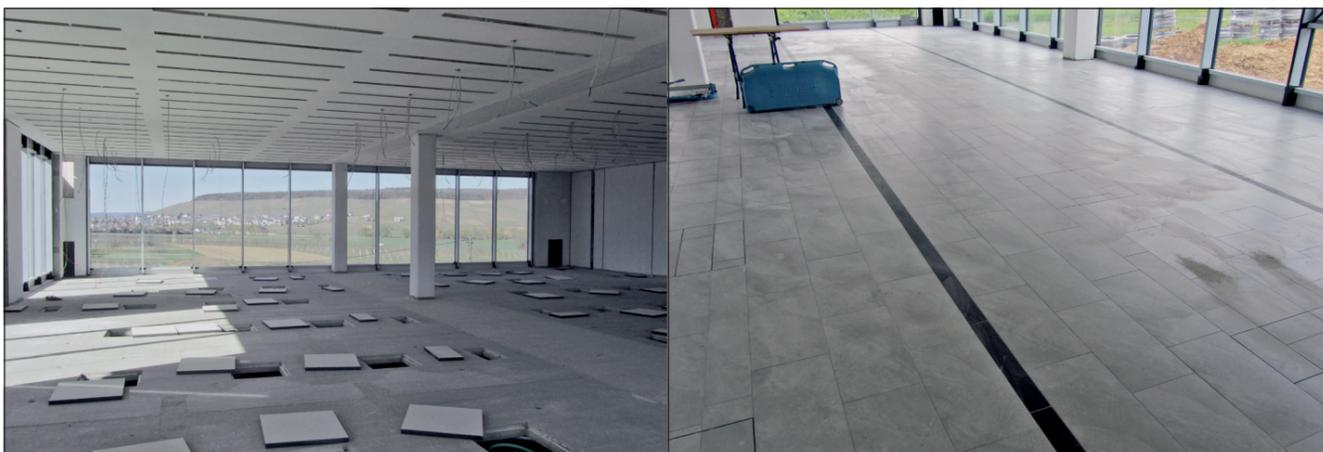
**„All in one“: Die komplett vorgefertigten Ceiltec-Elemente (hier Typ Ceiltec-B) integrieren bereits alle Leitungen für die gesamte technische Gebäudeausrüstung der Büros.**
