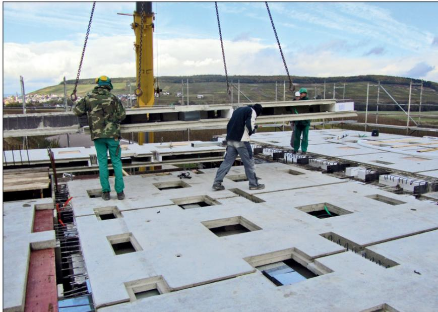
**Kürzeste Bauzeiten und einfache Montage vor Ort: Das Ceiltec-Deckensystem (hier Typ Ceiltec-B) wird fix und fertig direkt zur Baustelle nach Osann-Monzel geliefert.**
