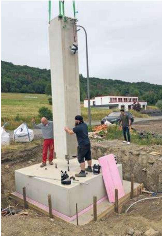
Montage der vorgefertigten Bauteile für die Säule.
