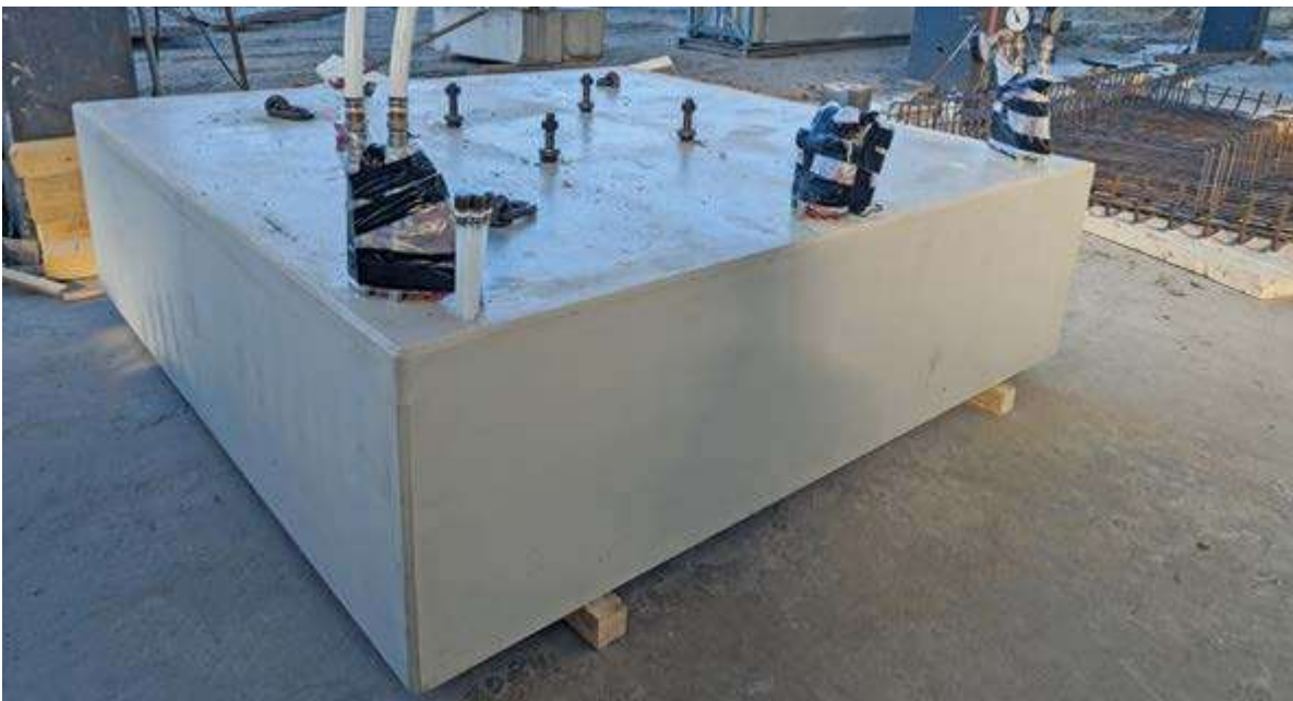
Vorgefertigter Fundamentblock für die Säule.
