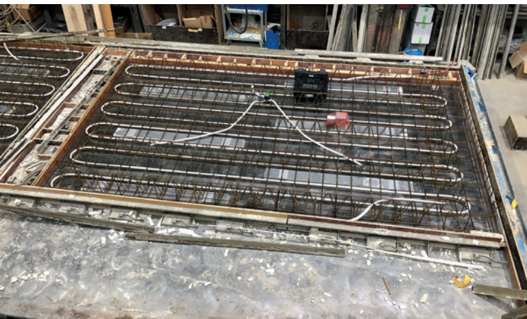
Fotodokumentation einer Einzelplatte mit allen Einbauteilen
