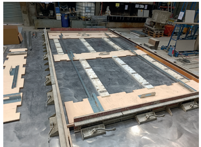
Schablone für die Positionierung der Schalungen für die Akustikabsorber
