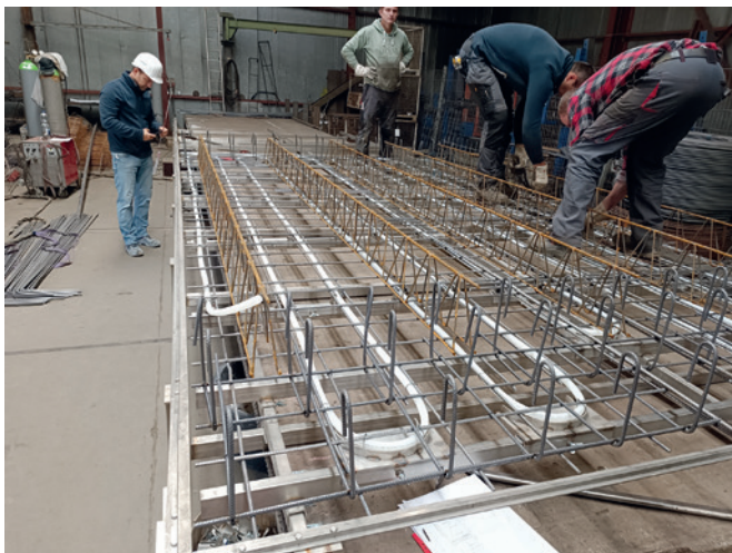
Schablone für die Herstellung der Heizleitungen in Verbindung mit der Vorbereitung der Bewehrung
