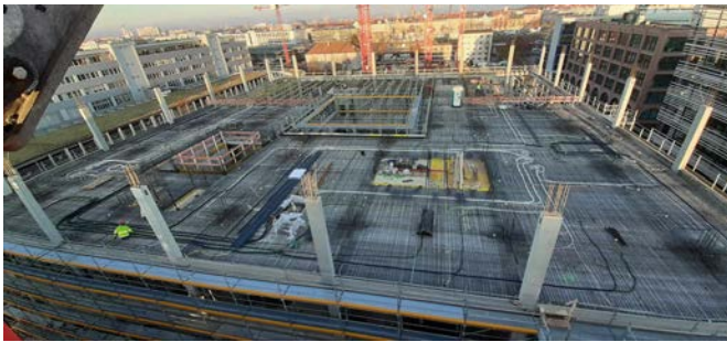
Bild 7 Verbindung und Koppelung der Leitungen über die Fugen hinweg nach dem Verlegen der vorgefertigten Deckenplatten Connection and coupling of the lines across the joints after laying the prefabricated ceiling tiles
