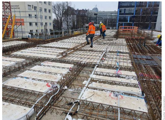
Bild 14 Einsatz einer Rollbewehrung zur Beschleunigung des Bauablaufs Use of rolling reinforcement to accelerate the construction process
