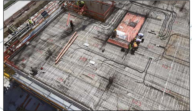
Konsequente Vorfertigung inkl. der bauteilintegrierten Komponenten der Haustechnik
