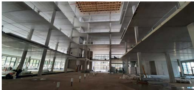
Bild 15 Sicht in das Innere eines Gebäudes mit Blick auf die vorgefertigten Deckenuntersichten View into the interior of a building with a view of the prefabricated ceiling soffits
