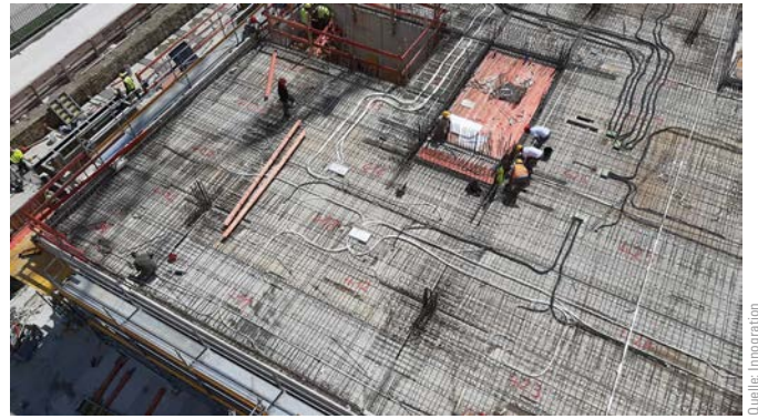
Bild 13 Verbinden der Leitungen nach dem Verlegen der vorgefertigten Deckenplatten Connecting the lines after laying the prefabricated ceiling tiles
