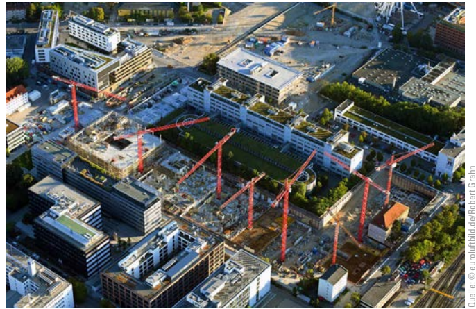
Bild 10 Luftbild mit Übersicht über die fünf Bürogebäude von ICampus und Rhenania Aerial view with overview of the five office buildings of ICampus and Rhenania
