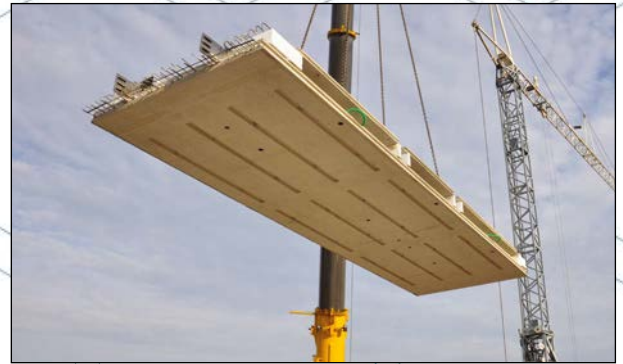
Ein stabiler und zugleich leichter Sandwichquerschnitt
