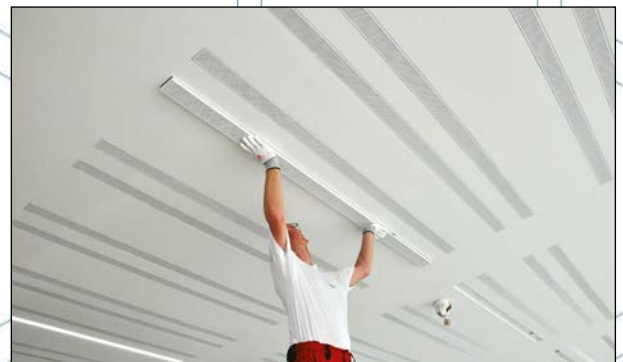
Dünne Metallstreifen über den integrierten Hohlräumen dienen als Schallabsorber
