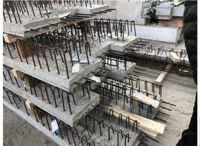
Bild 8 Vorgespannte Gurtstreifenplatten inklusive der im Werk integrierten Schubbewehrung Prestressed chord strip slabs including the shear reinforcement integrated in the factory
