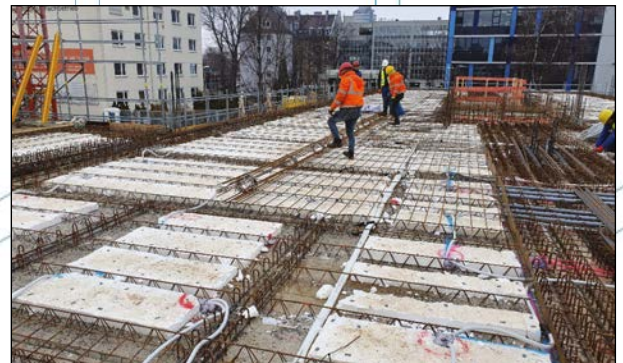
Verwendung von Bewehrungsmatten und von Rollbewehrung
