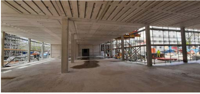
Bild 6 Vorrüstung der Aussparungen für die Akustikabsorber in der vorgefertigten Deckenplatte (Deckenuntersicht Rhenania) Prefitting of the recesses for the acoustic absorbers in the prefabricated ceiling panel (ceiling soffit Rhenania)
