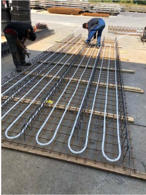
Bild 5 Herstellung der Rohrleitungen für die Bauteilaktivierung für den Einbau in den vorgefertigten Deckenelementen Production of the piping for the component activation for installation in the prefabricated ceiling elements
