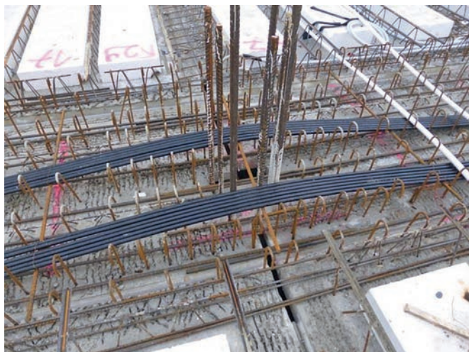
Bild 12 Höhenlage der Spannkabel über der Stütze, um den geplanten Neigungswinkel sicherzustellen Altitude of the prestressed cable above the support to ensure the planned angle of inclination
