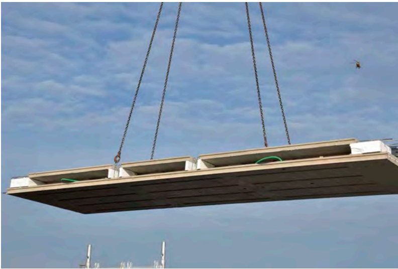
Abb. 5: Vorgefertigte Deckenelemente mit Sandwichquerschnitt
