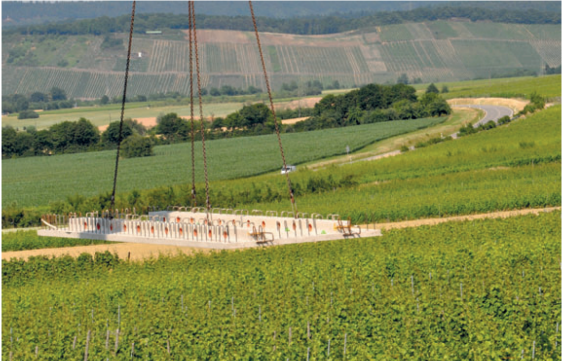
Vorgefertigte untere Platte, bereit für die Montage
