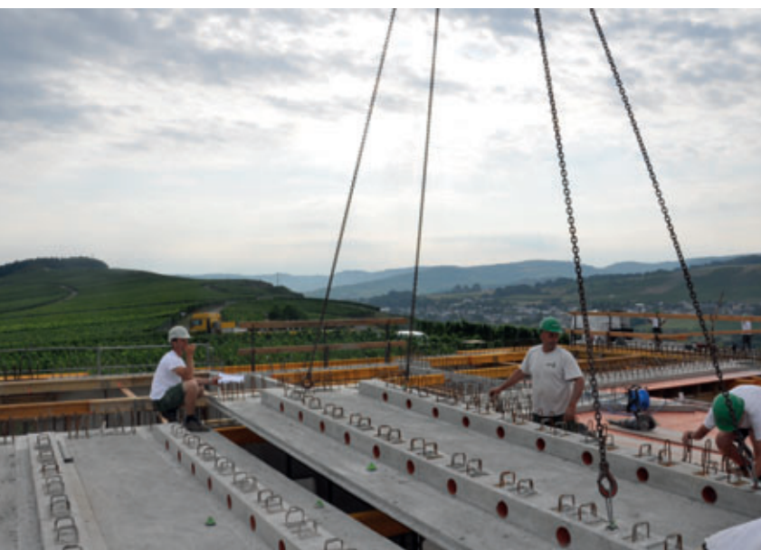
Montage der unteren Schale der Platte
