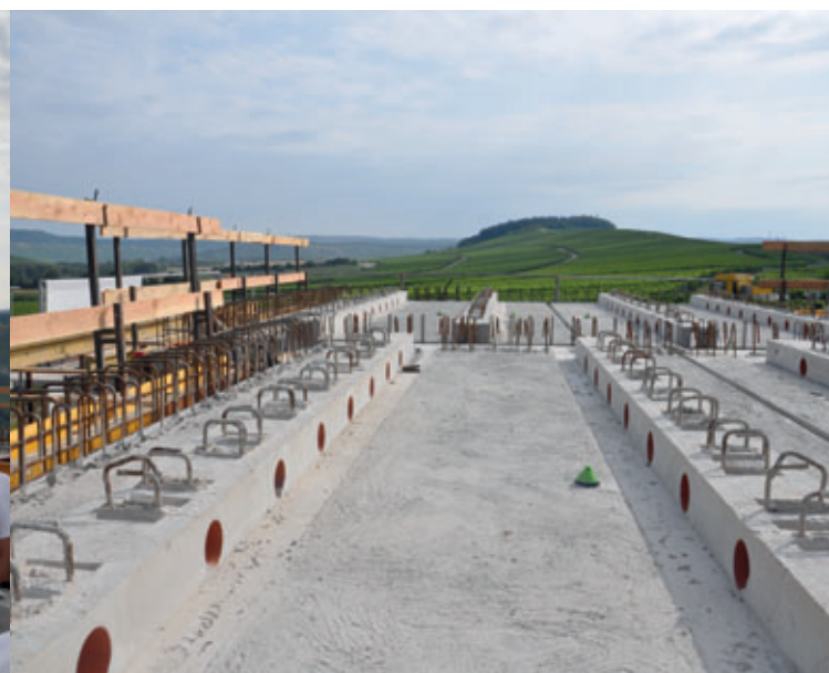
Deckenhohlraum zwischen den tragenden Rippen für die Montage der Haustechnikleitungen
