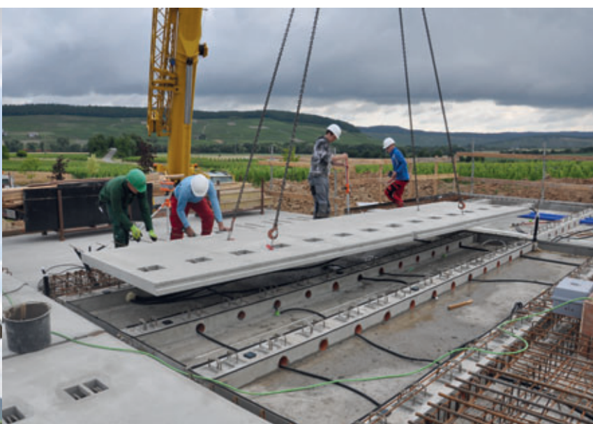
Montage der oberen Platte mit Abstützung auf den Rippen
