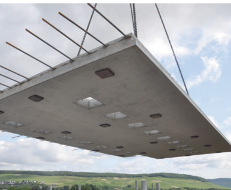
Passgenaue Platte für die obere Abdeckung mit den Öffnungen für den Schubverbund
