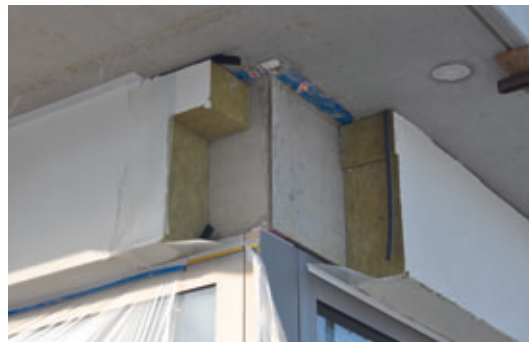
Heutige Gebäude mit entsprechend dicker Dämmung
