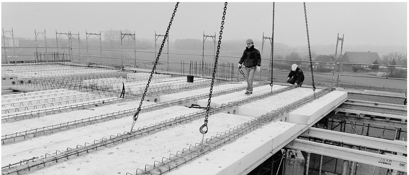
Große Spannweiten ganz nach Bauherren-Wunsch: Maßgeschneidert passt sich Ceiltec (hier Ceiltec-A) jedem Neubau und Spannweiten bis zu 20 m an. Fotos: Innogration
