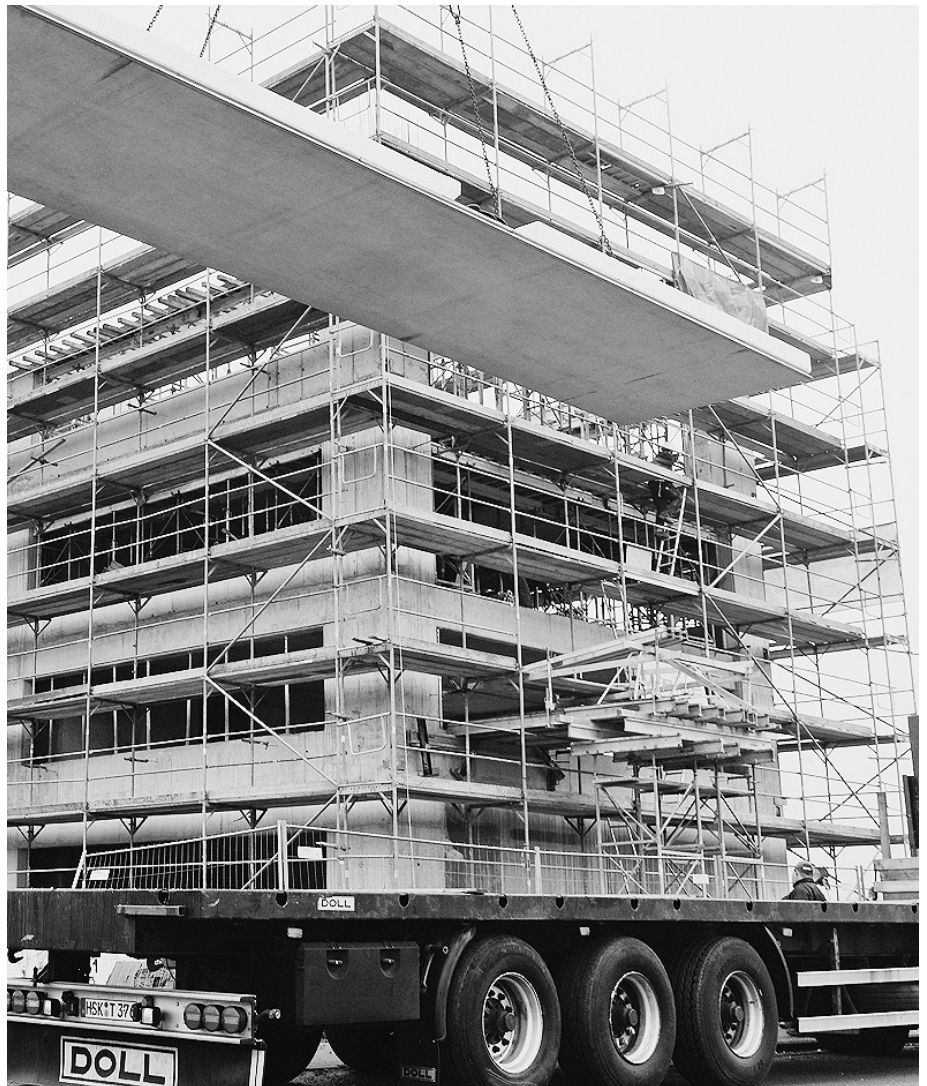
Das neue „Haus der Gewerkschaften“ in Münster – auf allen fünf Etagen kam die flexible Spannbeton-Fertigteildecke Ceiltec-A zum Einsatz.
