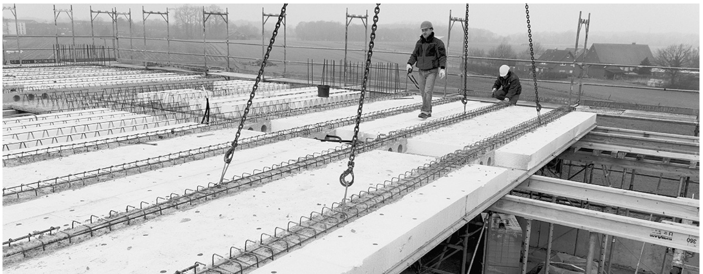
Große Spannweiten nach Bauherren-Wunsch: Maßgeschneidert passt sich Ceiltec-A dem Büro-Neubau an (Wunsch-Maß 12 m mal 2,49 m).
